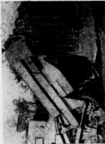
Minenräumpanzer am Panzerkampfwagen „Sherman“ in Marschstellung
